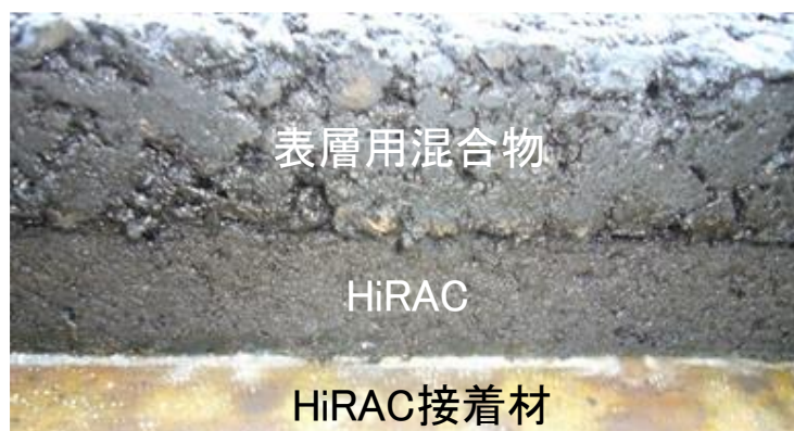
写真-1 HiRAC 舗装の断面
