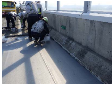
③HiRAC プライマーの塗布（端部）
