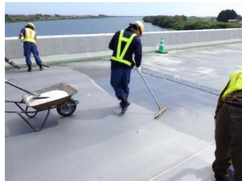
④HiRAC プライマーの塗布（床版面）
