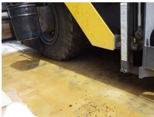
写真 1 施工時の防水面
