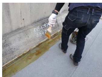
③HiRAC 接着材の塗布（端部）
