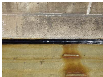
①端部防水層の施工 (L字型目地材の設置)
