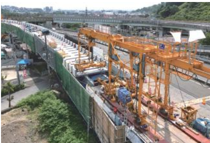
高速道路リニューアルプロジェクトによる PC床版取替工事
