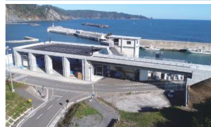
津波災害から人命を守る人工地盤
