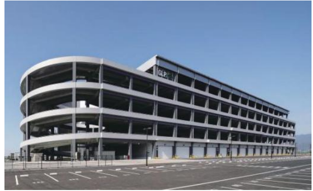
自由度が高く、高い保管効率が求められる物流倉庫に、PCaPC+免震構造が採用された
