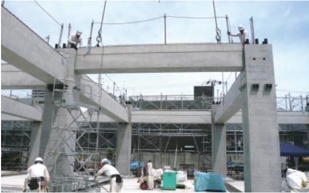
プレキャスト部材の組立状況
