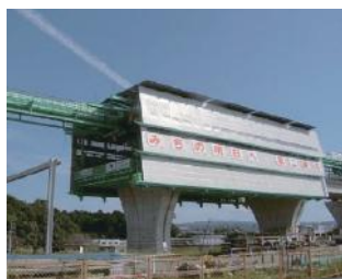
移動支保工を用いた省力化施工
