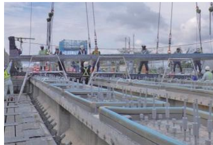
PC合成桁橋の床版取替えの施工例
