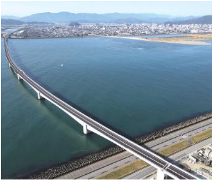
ミッシングリンク解消のため 河口に架橋されるPC橋
