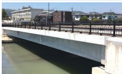
フライアッシュコンクリートを採用し高い耐久性を実現した橋梁
