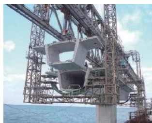
スパンバイスパン工法による省力化施工
