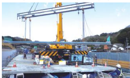
高品質であるプレキャストPC床版への取替え
